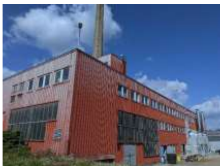
Obr.2 – Objekt Energo centra.
